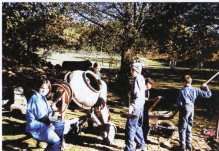
Freiburger Straßenkinder auf ihrer Zwergziegenstall-Baustelle in Aktion.
