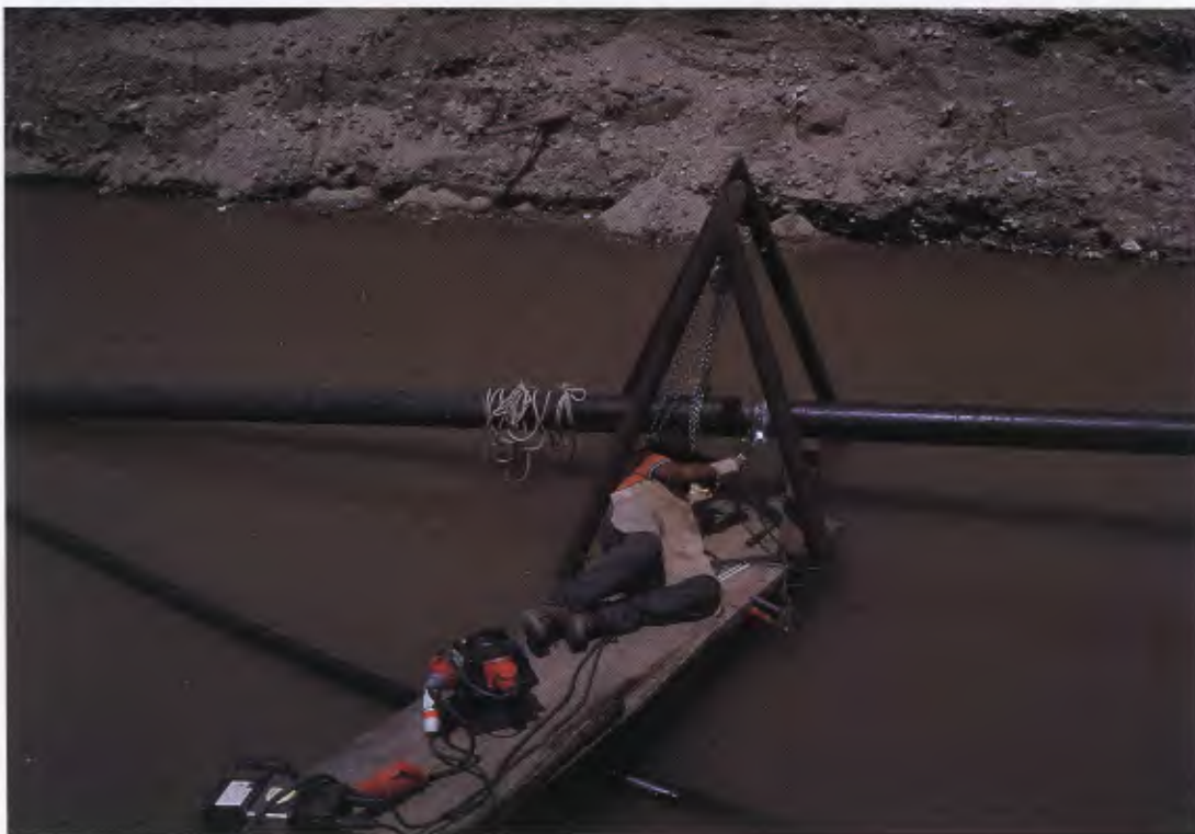
Knochenarbeit: Bau der Wasserleitung nach Wiwili
